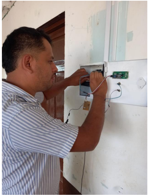
Ilustración 10: montaje de servidor en el punto Palmichal (Fuente: elaboración propia)
