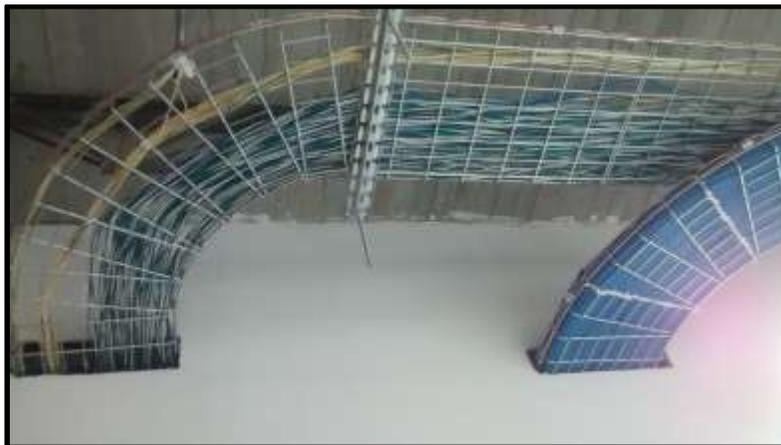
*Ilustración 10 bandeja porta cable implementada en la red
