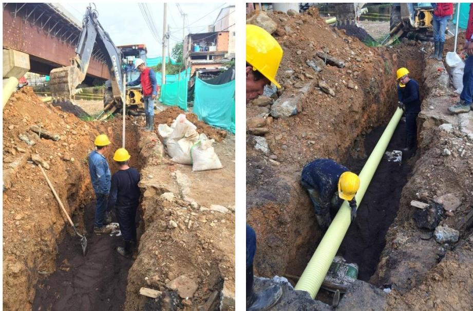
Fotografía 10. Nivelación y colocación de tubería para alcantarillado sanitario. Fuente: Propia
