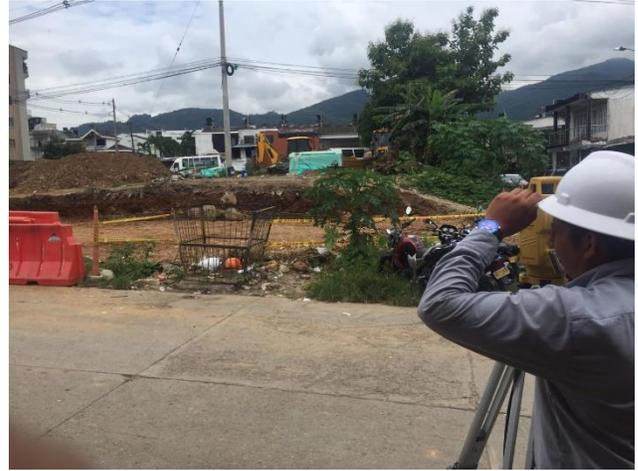
Fotografía 1. Localización y replanteo a partir del equipo topográfico. Fuente: Propia
