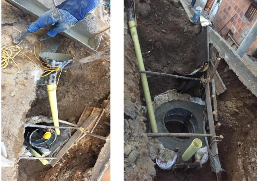
Fotografía 17. Fundida de pozo de inspección para alcantarillado sanitario. Fuente: Propia
