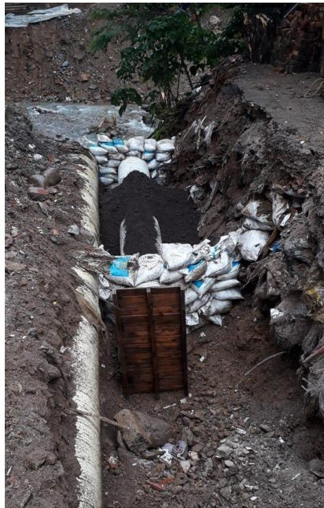
Fotografía 19. Nivelación y colocación de tubería en punto de descole para alcantarillado pluvial.
