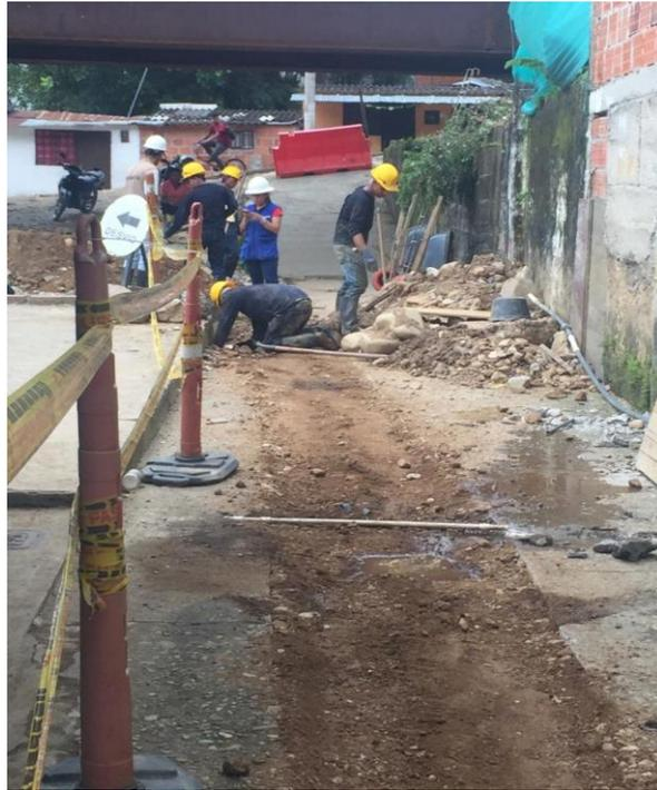
Fotografía 8. Relleno con material de la excavación para alcantarillado sanitario. Fuente: Propia
