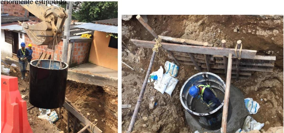
Fotografía 16. Formaleta para pozo de inspección para alcantarillado sanitario. Fuente: Propia
