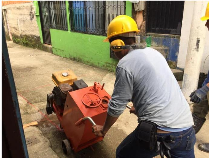
Fotografía 2. Corte del pavimento para alcantarillado sanitario. Fuente: Propia
