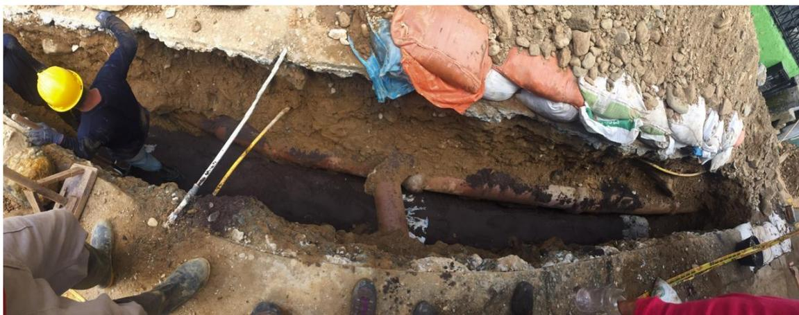
Fotografía 6. Tubería nivelada y con su cama de arena para alcantarillado sanitario. Fuente:
