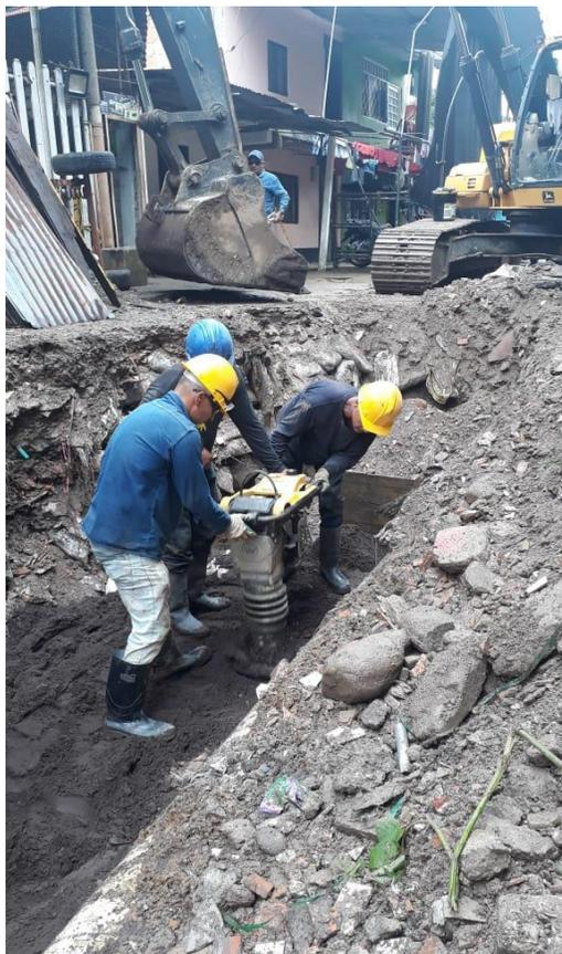
Fotografía 20. Compactación cama de arena en punto de descole para alcantarillado pluvial. Fuente: Propia
