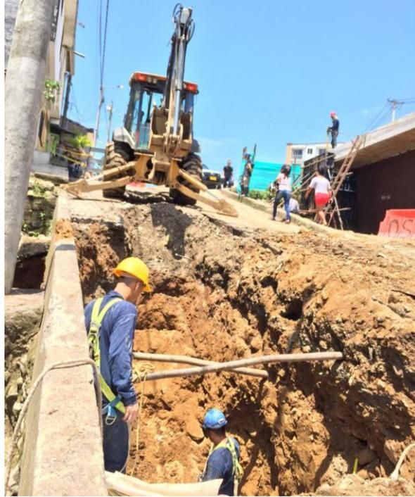
Fotografía 12. Excavación para pozo de inspección para alcantarillado sanitario. Fuente: Propia
