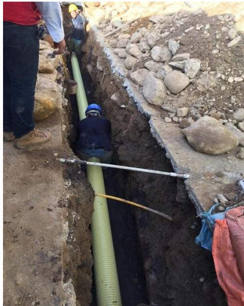
Fotografía 5. Ensamble de tubería para alcantarillado sanitario. Fuente: Propia
