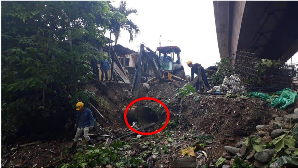
Fotografía 18. Excavación en punto de descole para alcantarillado pluvial. Fuente: Propia
