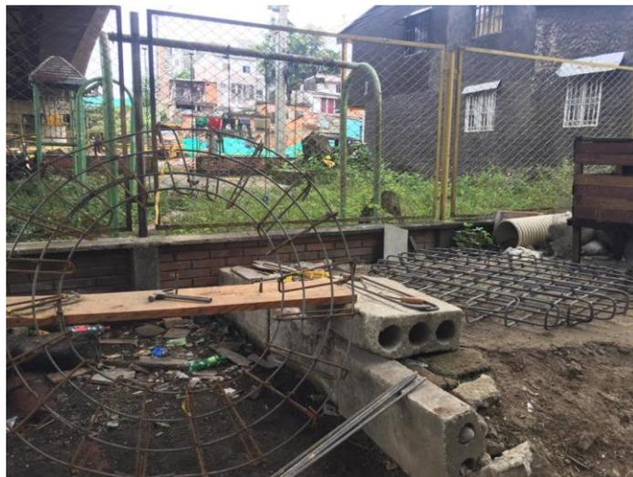
Fotografía 13. Base y tapa pozo de inspección para alcantarillado sanitario. Fuente: Propia
