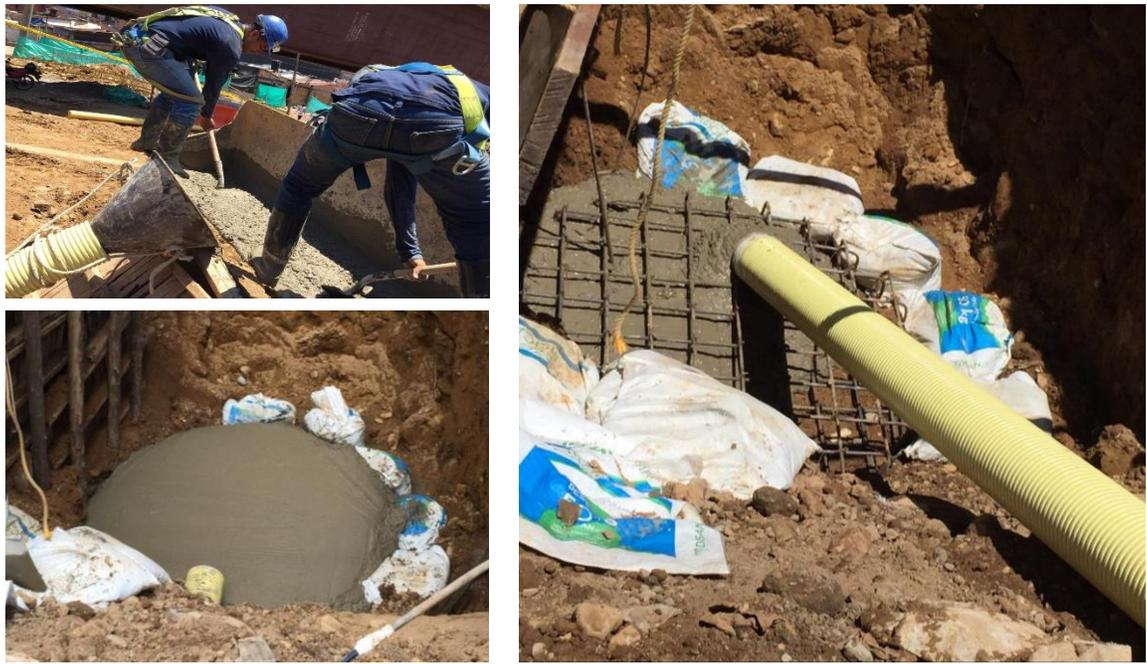
Fotografía 15. Fundida base de pozo de inspección para alcantarillado sanitario. Fuente: Propia
