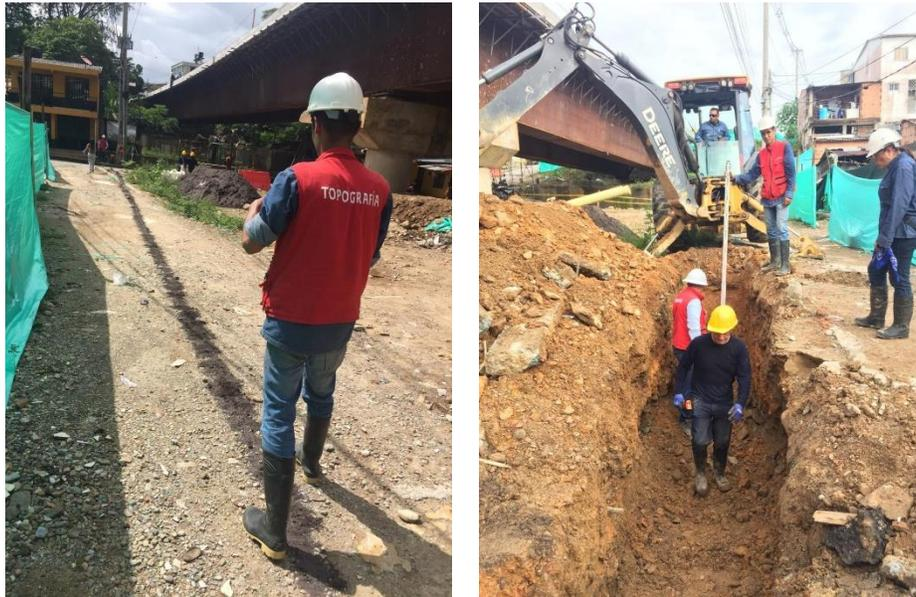
Fotografía 9. Delimitación de línea de trabajo y excavación para alcantarillado sanitario. Fuente: Propia
