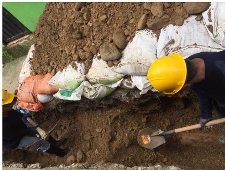
Fotografía 3. Retiro de material para alcantarillado sanitario. Fuente: Propia
