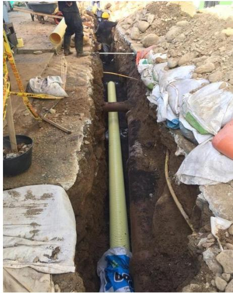
Fotografía 4. Colocación de tubería para alcantarillado sanitario. Fuente: Propia
