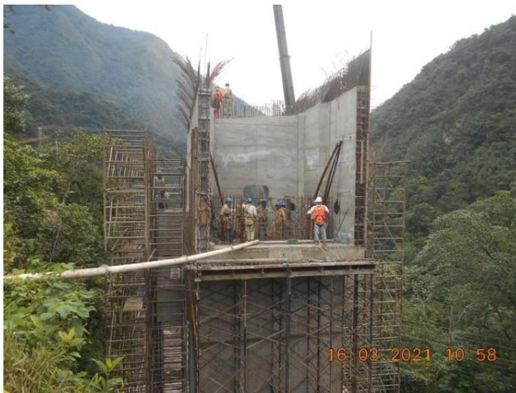
*Ilustración 3 Puente 5: Eje #5; Funden la primer y segunda sección de los muros de la dovela # 0 y 1*
