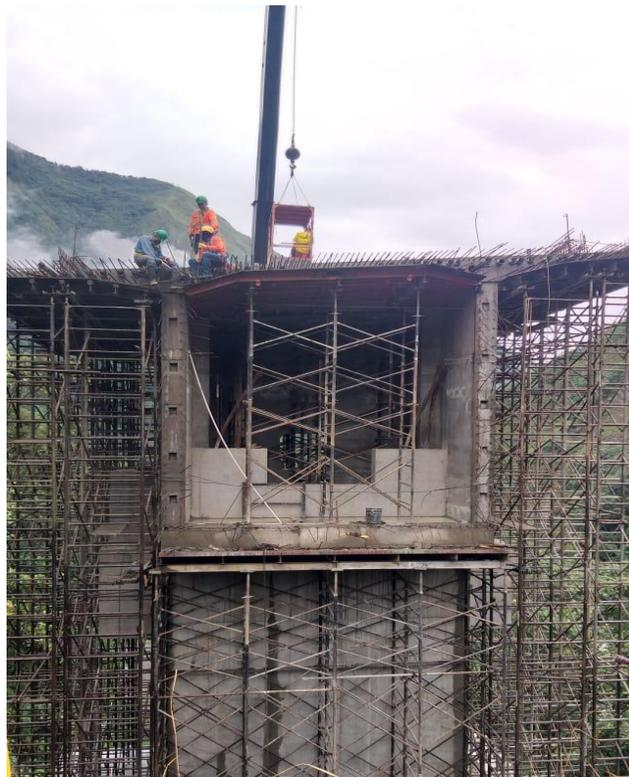
*Ilustración 10 Puente 5: Eje #5; fundida de losa superior de la dovela 0 y 1.*
