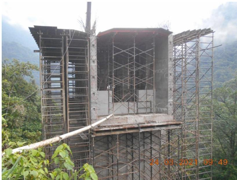
*Ilustración 6 Puente 5: Eje #5; armado de estructura provisional para la losa superior de la dovela 0 y 1.*
