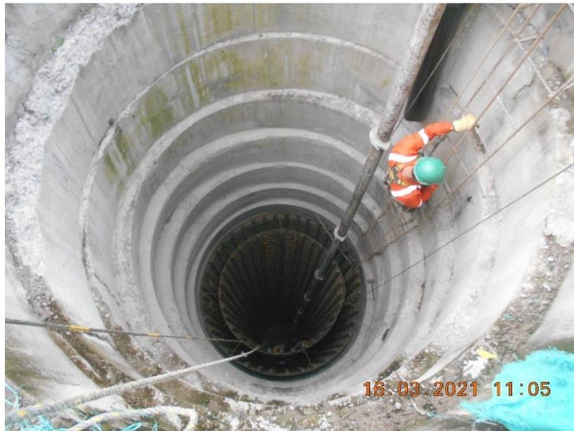
*Ilustración 5 Puente 5: Eje #6; Armado de acero y fundida para el primer tramo de núcleo del Caisson.*
