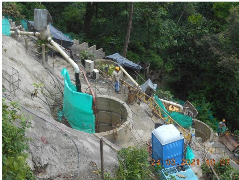
*Ilustración 8 Puente 5: eje #6; Excavación manual y fundida de anillos de Caisson.*
