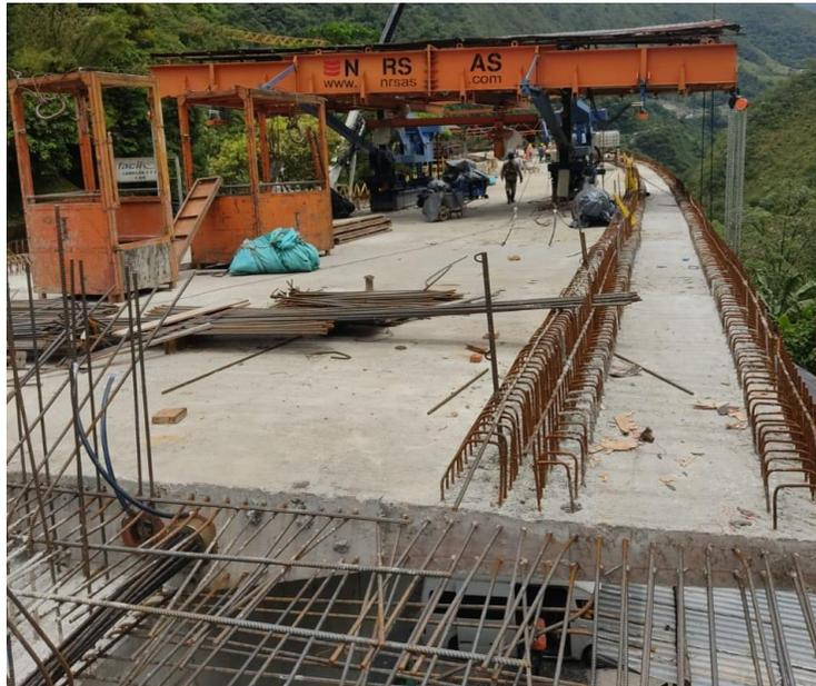
*Ilustración 9 dovela sobre cabezal.*
