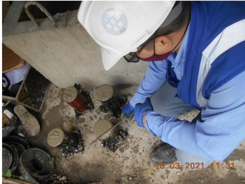
*Ilustración 7 se realiza toma de muestras de los concretos aplicados en los anillos de los Caisson.*
