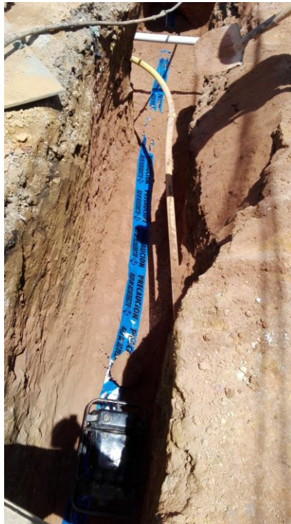
Imagen 5. LLENO Y COMPACTACION DE ZANJA ABIERTA, CONSTRUCCION SISTEMA DE ACUEDUCTO RED MATRIZ CUATRO ESQUINAS- SANTA ANA. Fotografía. Fuente: elaboración propia.
