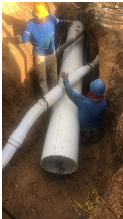
Imagen 3. INSTALACION DE TUBERIA DE 20”, CONSTRUCCION SISTEMA DE ACUEDUCTO RED MATRIZ CUATRO ESQUINAS- SANTA ANA. Fotografía. Fuente: elaboración propia.
