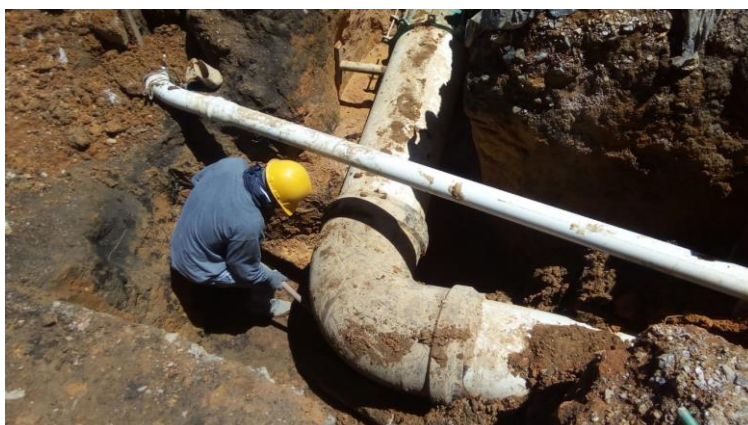
Imagen 4. INSTALACION DE CODO DE 20"X90°, CONSTRUCCION SISTEMA DE ACUEDUCTO RED MATRIZ CUATRO ESQUINAS- SANTA ANA. Fotografía. Fuente: elaboración propia.
