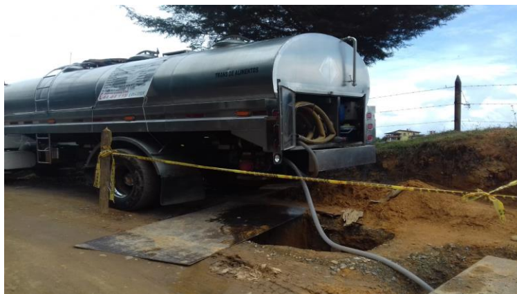
Imagen 6. LLENO DE TUBERIA PARA PRUEBA DE PREZURIZACION, CONSTRUCCION SISTEMA DE ACUEDUCTO RED MATRIZ CUATRO ESQUINAS- SANTA ANA. Fotografía.
