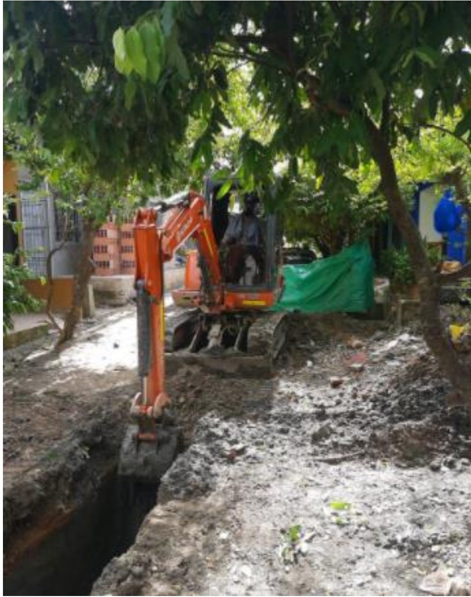
Figura 3. Excavación de zanja para instalación de tubería de la construcción del sistema para manejo de aguas residuales urbanas del municipio de Nechí, Antioquia (Fuente: registro fotográfico de la empresa).
