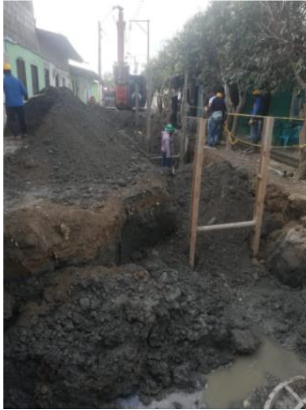
Figura 4. Supervisión de la actividad de excavación en la construcción del sistema para manejo de aguas residuales urbanas del municipio de Nechí, Antioquia (Fuente: Elaboración propia).
