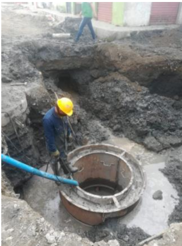
Figura 5. Bombeo de agua en excavación en la construcción del sistema para manejo de aguas residuales urbanas del municipio de Nechí, Antioquia (Fuente: Registro fotográfico de la empresa).
