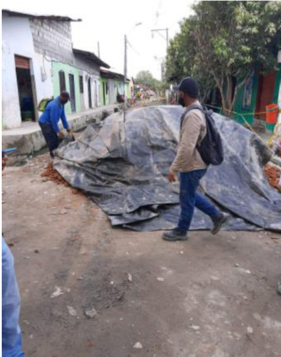
Figura 6. Protección de material seleccionado para lleno en la construcción del sistema para manejo de aguas residuales urbanas del municipio de Nechí, Antioquia (Fuente: Registro fotográfico de la empresa).
