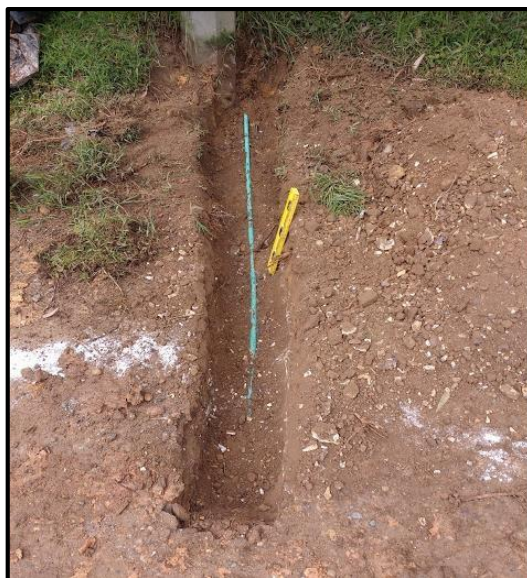
Imagen 2. NICHOS DE EXPLORACIÓN SOBRE LINEAMIENTO DE TUBERÍA, CONSTRUCCIÓN DE SISTEMA DE ACUEDUCTO CUATRO ESQUINAS, SANTA ANA. Fotografía. fuente: Elaboración Propia.
