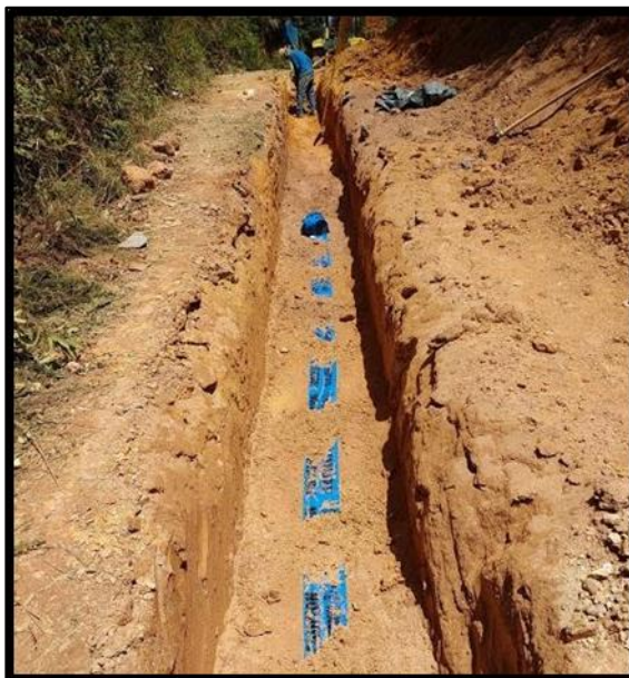
Imagen 4. COMPACTACIÓN DE MATERIAL PROVENIETE DE EXCAVACIÓN. CONSTRUCCIÓN DE SISTEMA DE ACUEDUCTO CUATRO ESQUINAS, SANTA ANA. Fotografía. Fuente: Elaboración Propia.
