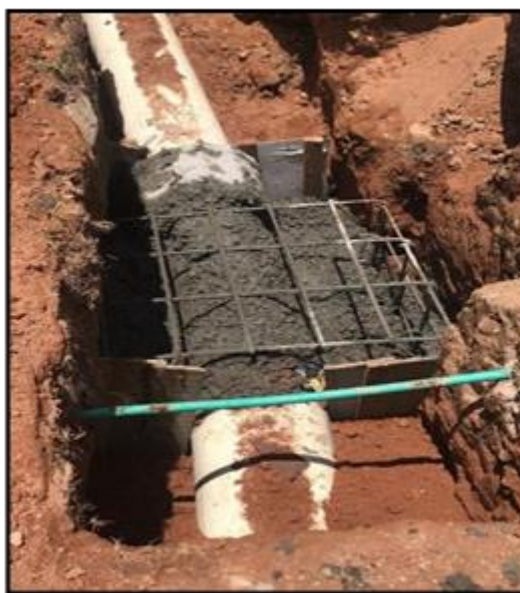
Imagen 3. ATRAQUE O EMPOTRAMIENTO PARA CODO DE 20"X11°. CONSTRUCCIÓN DE SISTEMA DE ACUEDUCTO CUATRO ESQUINAS, SANTA ANA. Fotografía. Fuente: Elaboración Propia.
