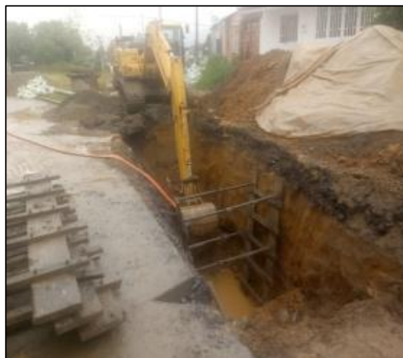
Ilustración 9 Excavaciones con maquinaria y entibados
