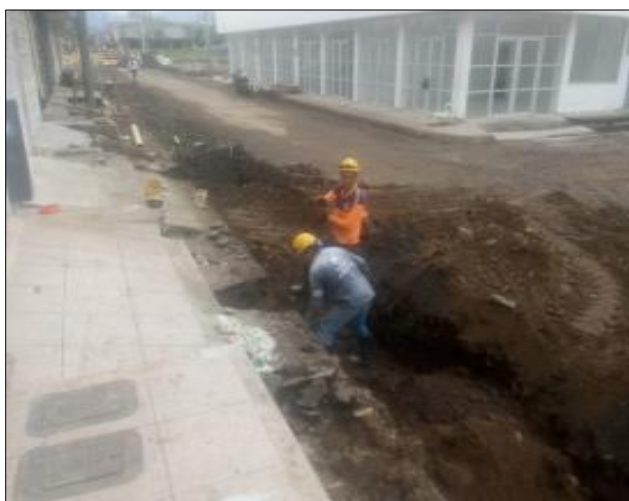
Ilustración 8 Excavación manual por domiciliarias
