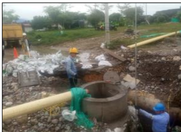
Ilustración 14 Construcción de Pozo
