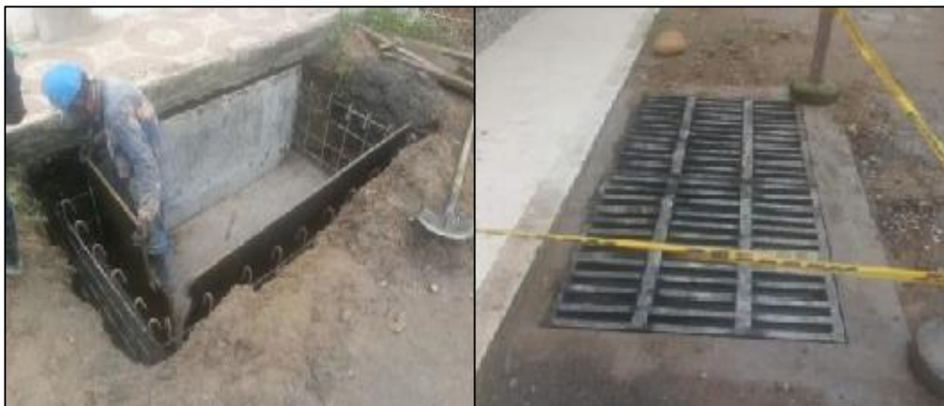
Ilustración 13 Elaboración de alcantarillas
