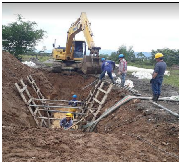
Ilustración 10 Drenaje de aguas posadas
