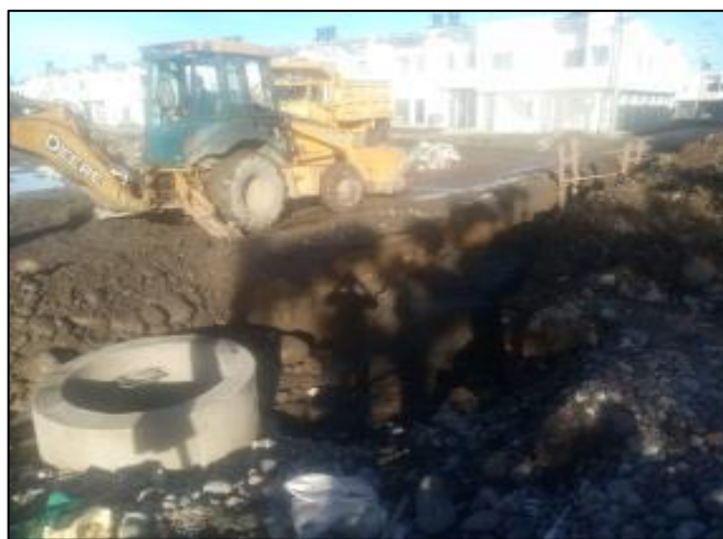
Ilustración 15 Construcción de Pozo
