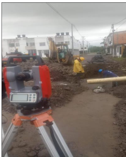
Ilustración 6 Verificación de topografía
